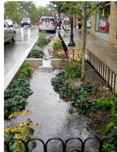
Esempio di rain garden per il filtraggio dell'acqua di dilavamento stradale
